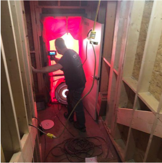
Left: Blower Door Testing
