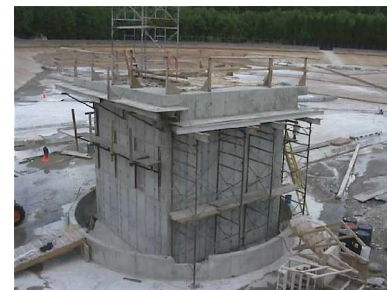
New 90” Valve Structure
